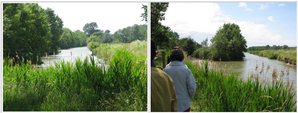
Canal d'alimentation de la station de pompage (collecte des eaux du marais)
